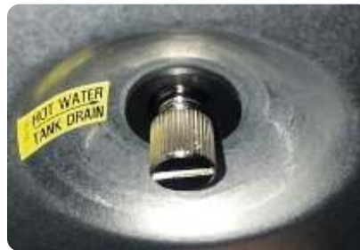
SB19A0 nadpultni aparat Ventil na dnu, ispod aparata.
